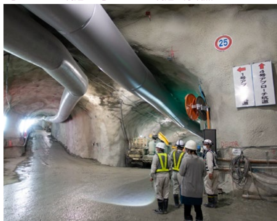
1号アプローチ坑道と4号アプローチ坑道の分岐点。
