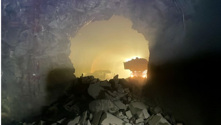
貫通したアプローチ坑道。
